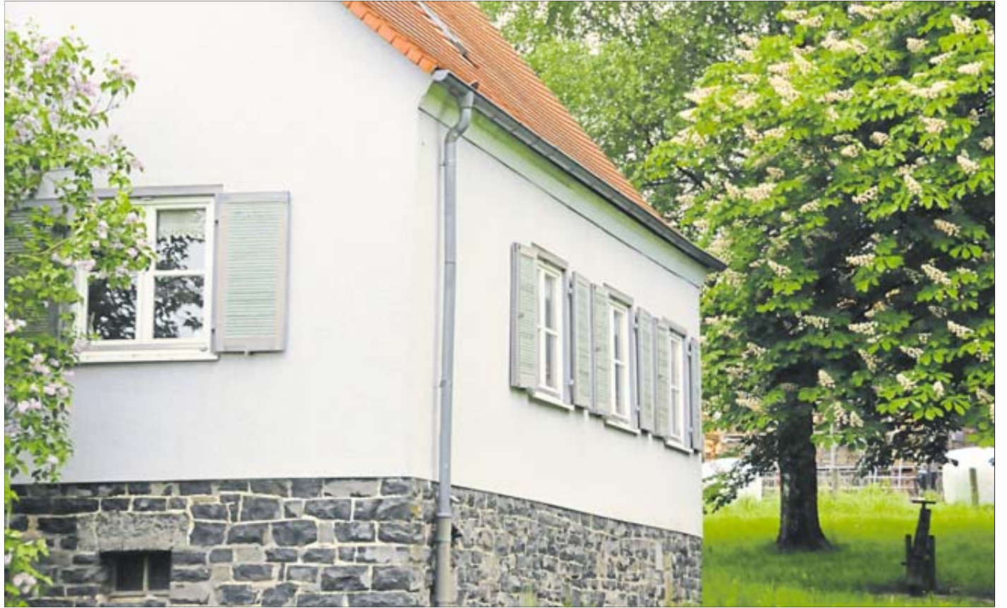
Der ehemalige Kindergarten in Gundhelm wurde 1936 erbaut. Jetzt soll das Gebäude samt Grundstück verkauft werden. Für die Stadt entwickelt sich das Geschäft zu einer „hoch unwirtschaftlichen Maßnahme“. Foto: Alexander Gies
